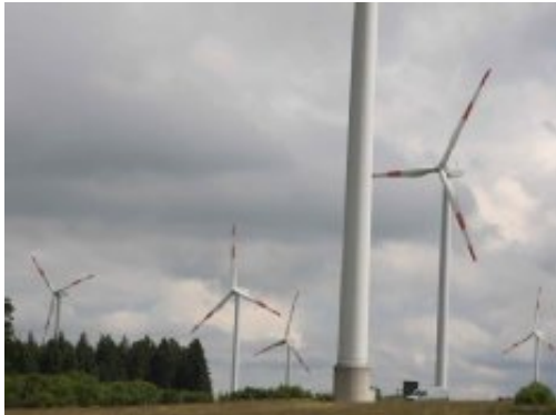
Zwölf der 18 Anlagen im Windpark Schöneiseiffen werden abgebaut. (Archivfoto: Hilgers)
