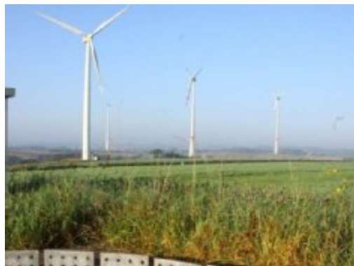
Nur noch die Fundamente stehen im Windpark von Herhahn, der 1991 die Windkraftära in der Eifel mit einläutete. Foto: Stephan Everling
