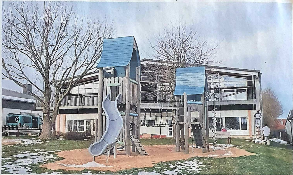
Das Gerüst steht noch: Derzeit werden noch die letzten Arbeiten an der Kindertagesstätte in Dreiborn durchgeführt. Foto: Wolfgang Kirfel
